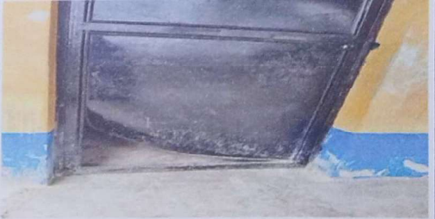
Foto 6: Se observa la puerta en deterioro total, desprendimiento.
