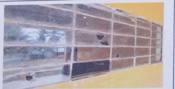
Foto 5: Se observa en area de ventana piezas de vidrio en mal estado,
